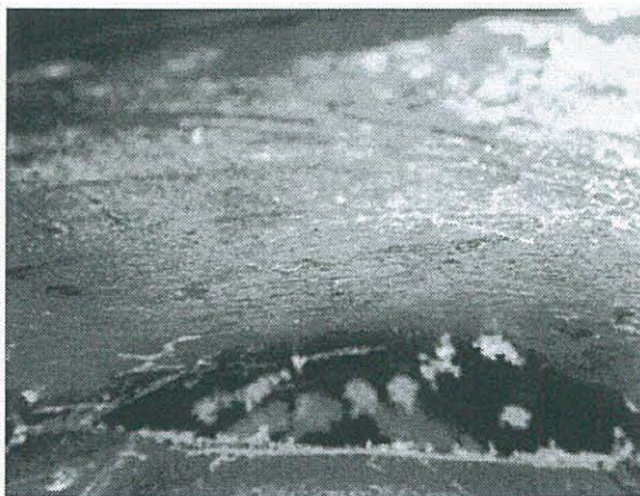
Tubulatura s-a încărcat cu grăsimi Trebuie curățată.
