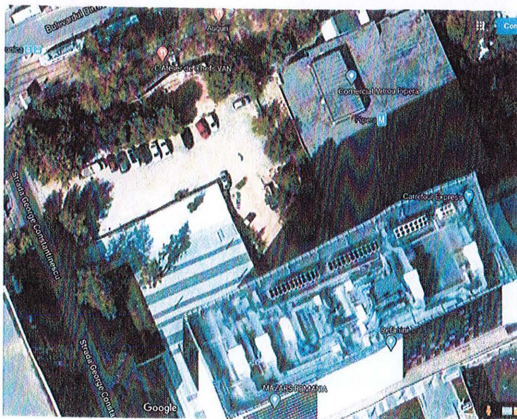
Imagine de sus, Cladirea B / parcare / statie de metrou.
