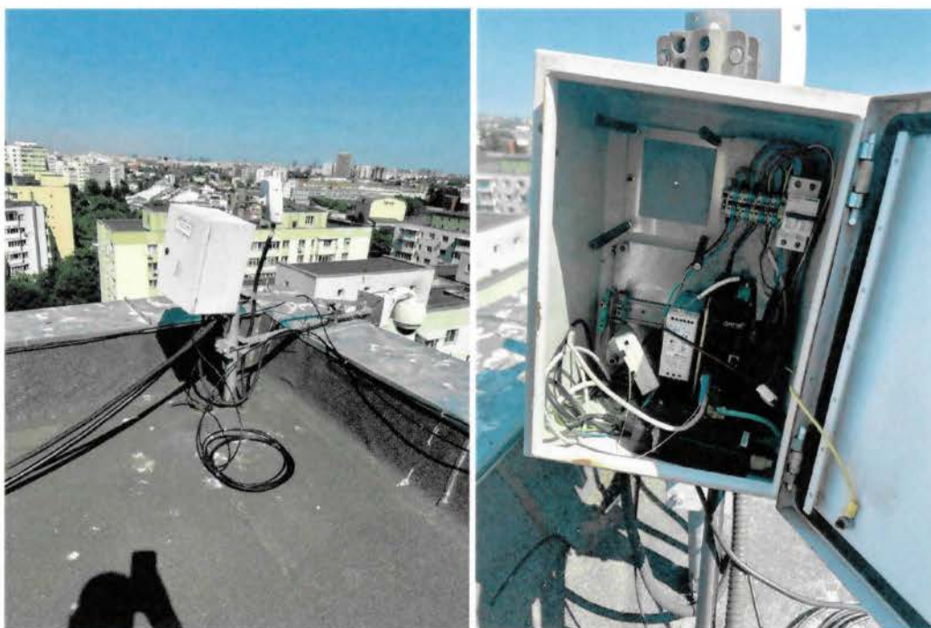
Figura 4 & 5. Exemplu cameră montată pe bloc și conținutul unei cutii de transmisiuni
