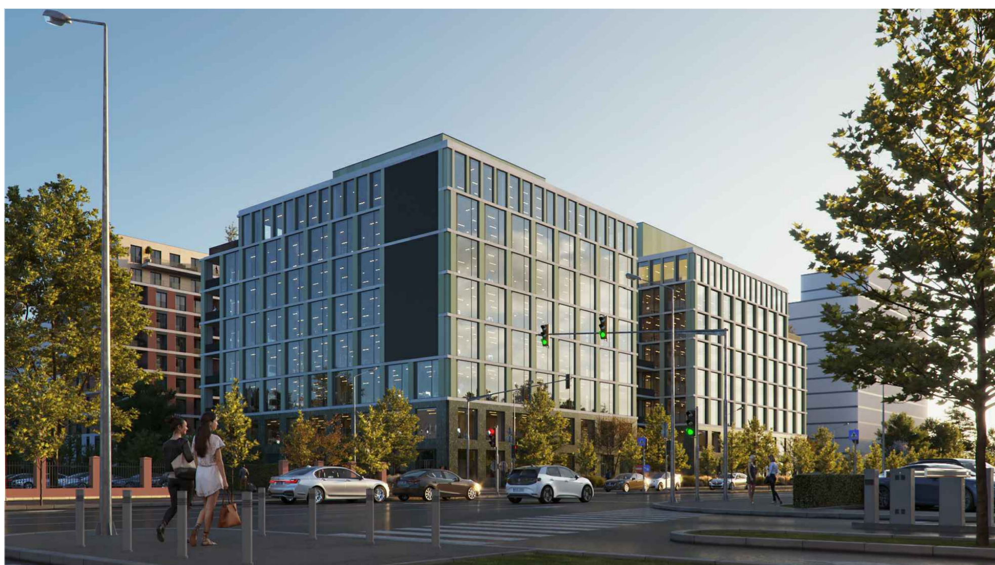
VEDERE ACCES PRINCIPAL
