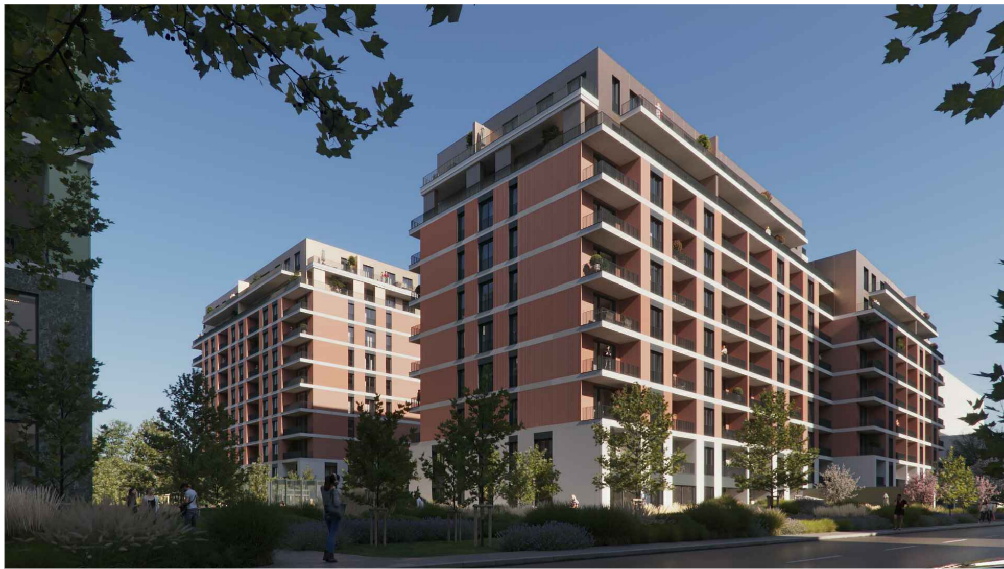
VEDERE ACCES PRINCIPAL
